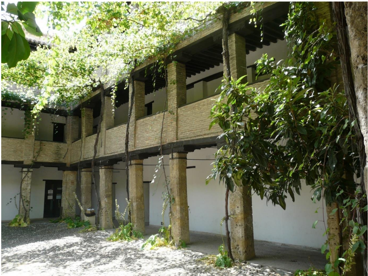
La cour intérieure du Corral del Carbon
