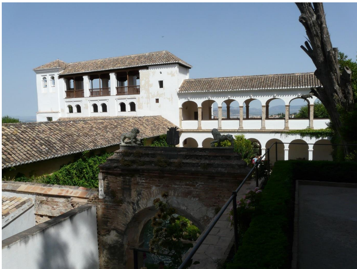
Vue générale du palais d'été
